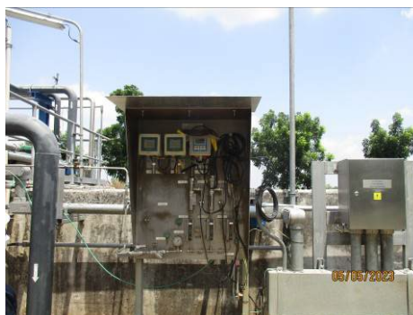
ภาพที่ 2-10 ระบบติดตามตรวจสอบคุณภาพน้ำทิ้งแบบต่อเนื่อง (Online Monitoring) บริเวณจุดระบายน้ำทิ้งของโครงการ
