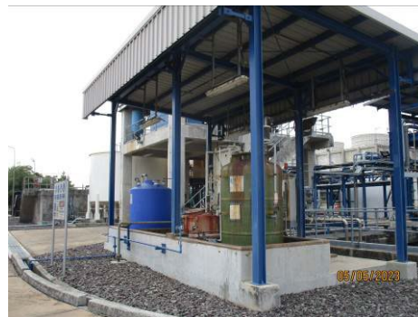
ภาพที่ 2-48 อาคาร/แทงค์จัดเก็บสารเคมีอันตราย
