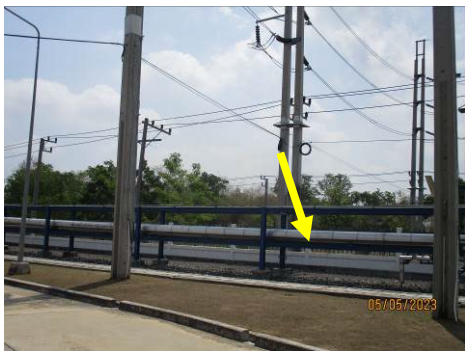
ภาพที่ 2-16 ระบบท่อระบายน้ำทิ้งจากโครงการไปยังคลองชุมพล (บริเวณฝายทดน้ำ)
